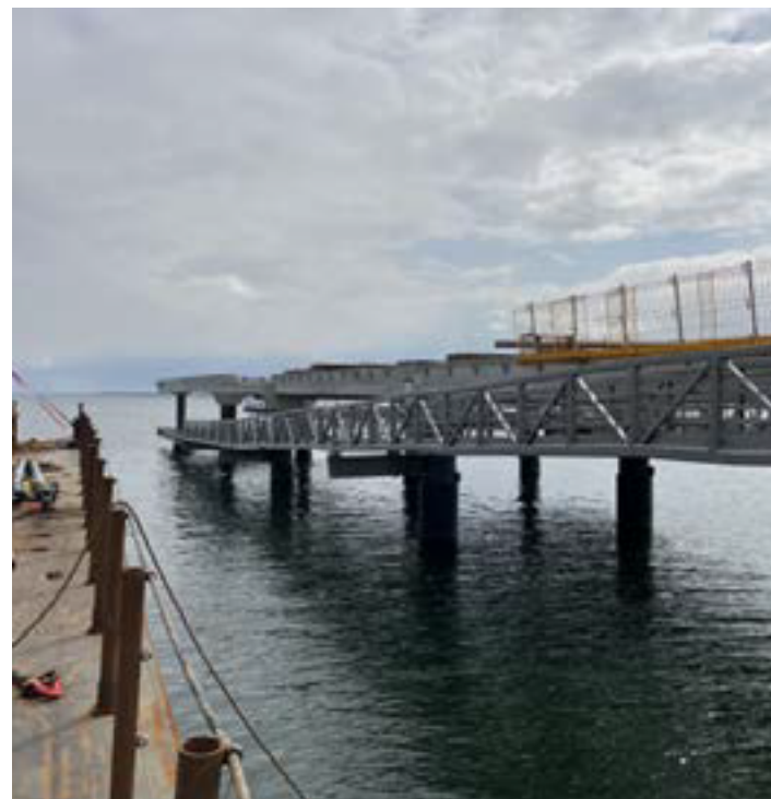
Verzinkte Stahlkonstruktionen während der Bauphase. © CHRISTMANN + PFEIFER
