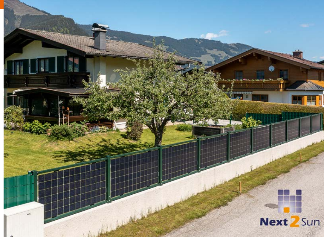
Solarzaun mit bifazialen Modulen als Grundstückabtrennung. Bildnachweis: © Next2Sun
