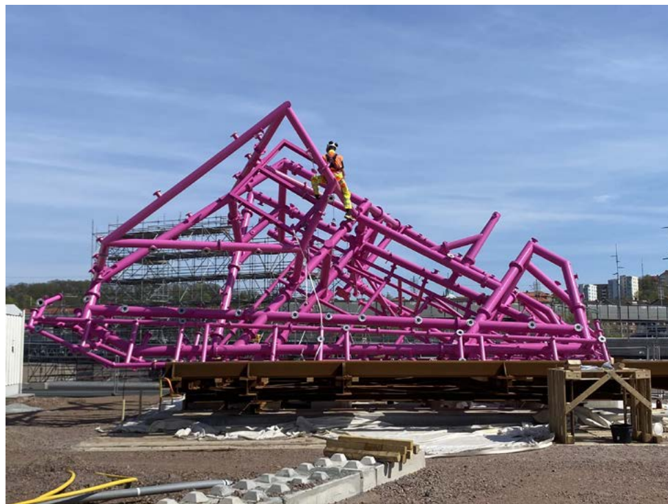
Bilder links: Blick in die Fertigungshalle bei Hahner Technik während der Entstehung von bLINK und während der Vormontage in Göteborg. © Hahner Technik
