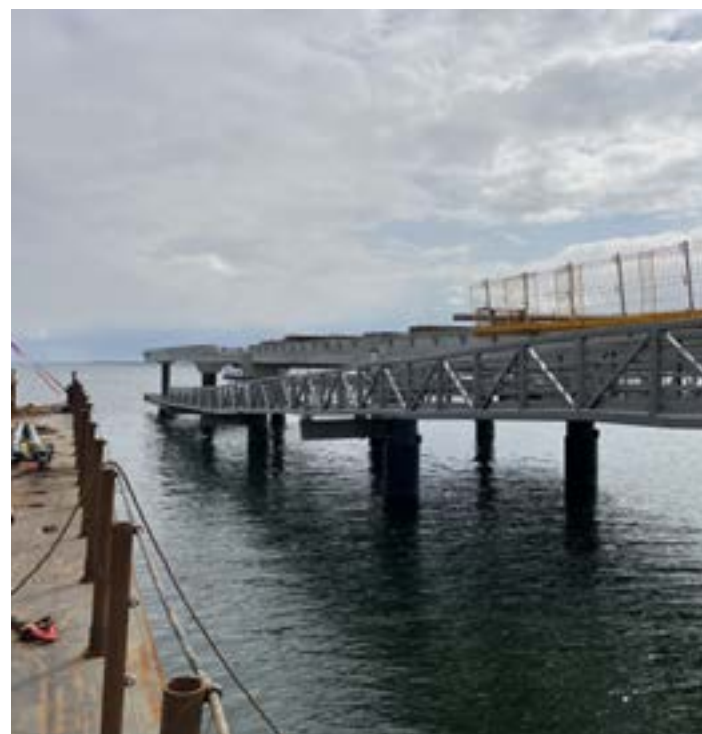
Verzinkte Stahlkonstruktionen während der Bauphase. © CHRISTMANN + PFEIFER
