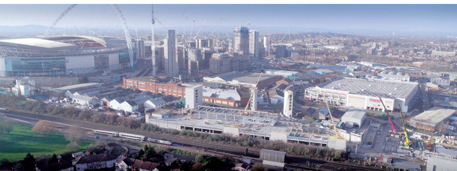
Blick auf die Großbaustelle in unmittelbarer Nähe zum Wembley-Stadion (links im Bild).
