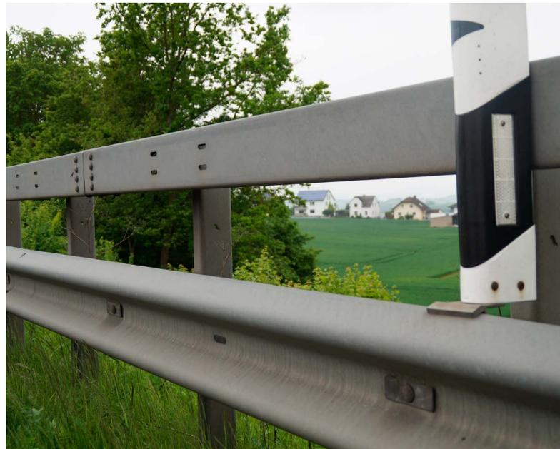
**Abb. 1:** Übersicht über Dünnschicht-microZINQ®-verzinktes Verkehrsrückhaltesystem.
