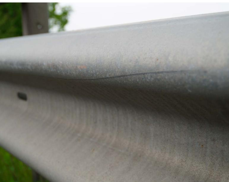
**Abb. 3:** Dünnschicht „microZINQ®“-verzinkte Schutzplanke mit Anfahrspur.
