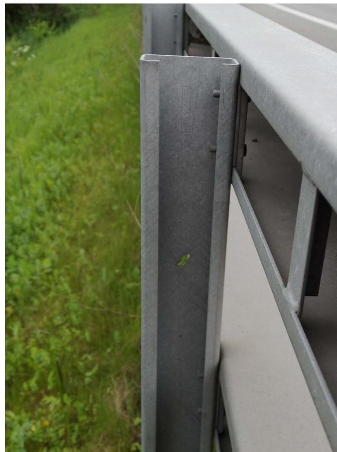
**Abb. 2:** Dünnschicht-„microZINQ®“-verzinkter C-Pfosten nach 10 Jahren.
