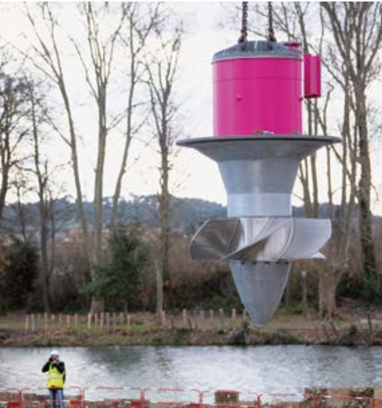
Installation der Turbine mit einem Laufraddurchmesser von 1.450 mm und eine installierte Leistung von 450 kW in Paicherou, das sich in der Stadt Carcassonne befindet. Das Wasserkraftwerk ist seit Januar 2019 in Betrieb.
