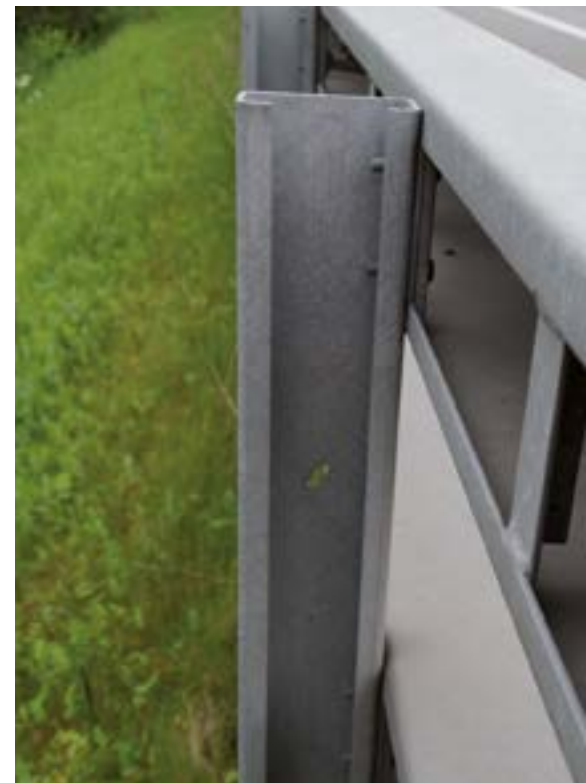
Abb. 2: Dünnschicht-„microZINQ“-verzinkter C-Pfosten nach 10 Jahren.
