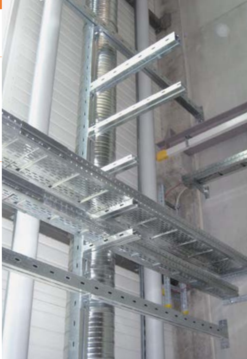
PILA-Montagesystem beim Endkunden.
