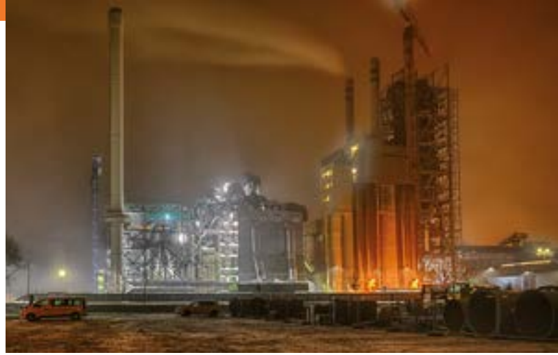
Das Foto zeigt unter anderem den beleuchteten 104 Meter hohen Wärmetauscherturm, für den insgesamt 1.765 Kubikmeter Beton und 2.100 Tonnen Stahl verbaut wurden.
