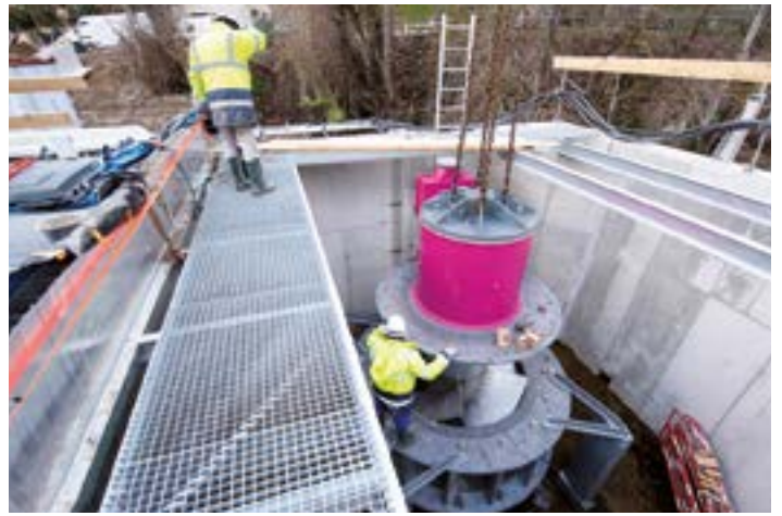
Installation der Turbine mit einem Laufraddurchmesser von 1.450 mm und eine installierte Leistung von 450 kW in Paicherou, das sich in der Stadt Carcassonne befindet. Das Wasserkraftwerk ist seit Januar 2019 in Betrieb.
