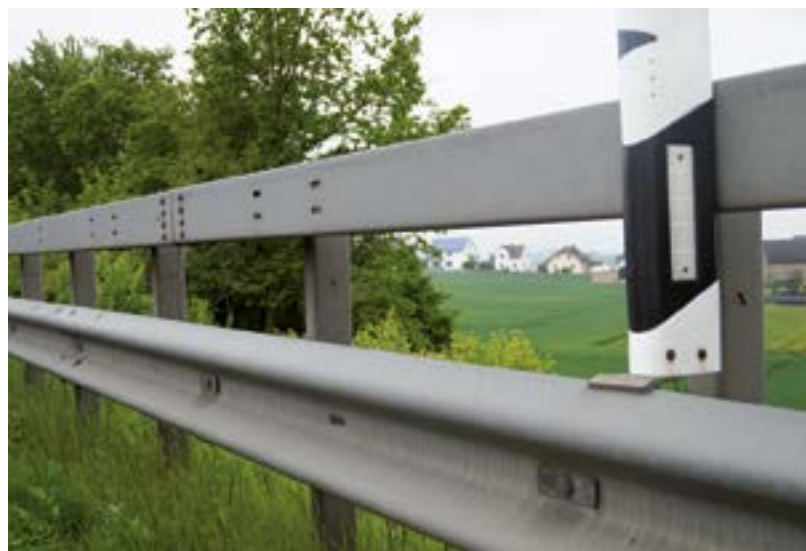
Abb. 1: Übersicht über Dünnschicht-microZINQ ® -verzinktes Verkehrsrückhaltesystem.
