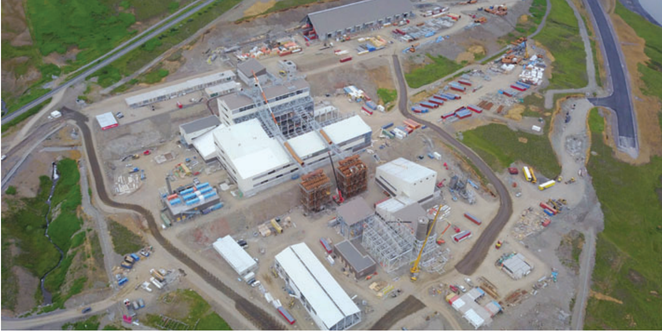
Die Baustelle aus der Vogelperspektive.
