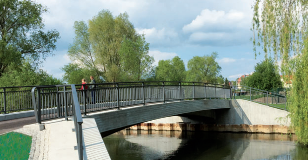
Ein Novum: VFT-WIB-Bauweise mit feuerverzinkter Stahlstruktur – Fertiggestellte Elsterbrücke in Osendorf.
