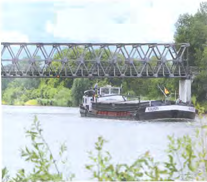
Bild 1. Rostfrei seit über 70 Jahren: stückverzinkte Ehzer-Brücke in Almen (NL)
