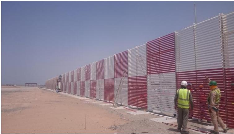
Windschutzzäune am Flughafen Maskat/Oman (Quelle: RSB, Dortmund) (Meeresnähe/Wüste, hochwetterfest beschichtet)
