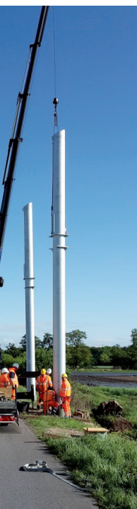
Aufbau der Masten an der Teststrecke (Bild rechts).
