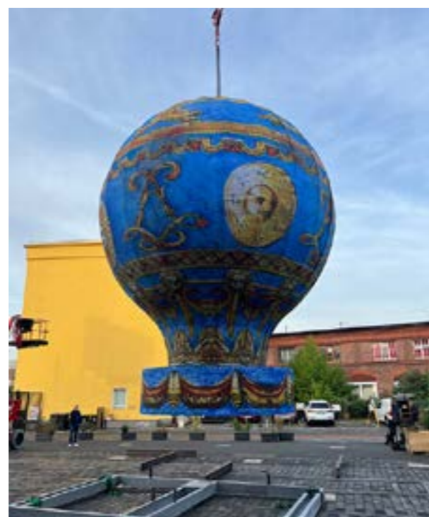
Den fertige Ballon am Haken, um diesen auf das Dach zu heben. (© C. Heider Metallbau GbR)
