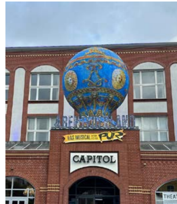
Die Montgolfière auf dem Dach des Foyers. (Bilder dieser Seite: © C. Heider Metallbau GbR)
