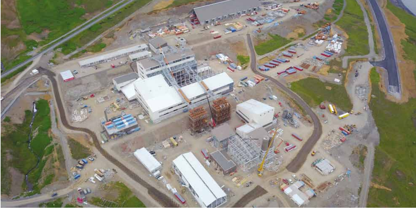
Die Baustelle aus der Vogelperspektive.
