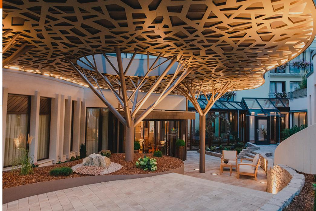
Indian Summer in Bad Bocklet: warme Farbgebung auf feuerverzinktem Untergrund. Der Dachaufbau besteht aus einer Trapezblech-Tragschale mit Dämmung und Gründach-Aufbau, nach unten wurde eine doppelschalige Konstruktion aus Aluminiumblechen abgehängt. (© Hotel Kunzmann's)
