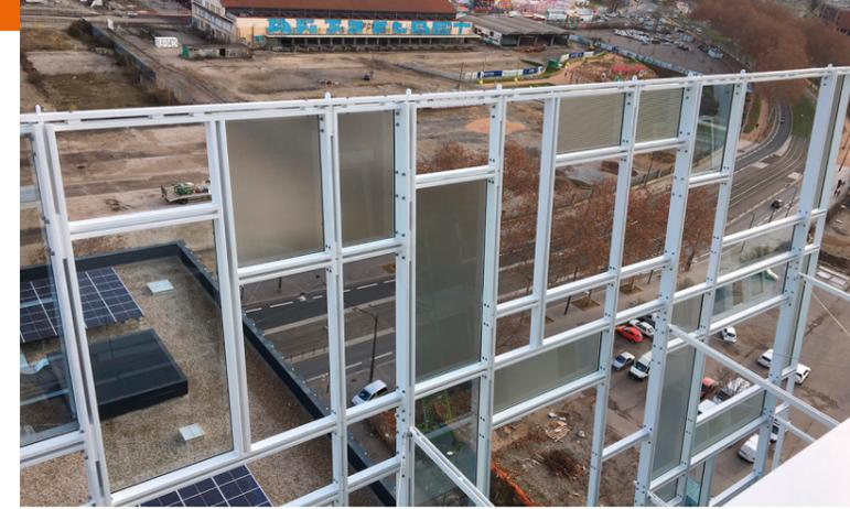
Äußere Fassadenhülle von „Ycone“ während der Bauarbeiten mit stückverzinkten und anschließend beschichteten Elementen in Weiß. (© ZINQ France)
