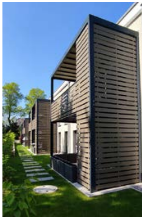
Sicht auf einen Teil der Balkone. (© Beckmann Stahl- und Metallbau, Wetter)
