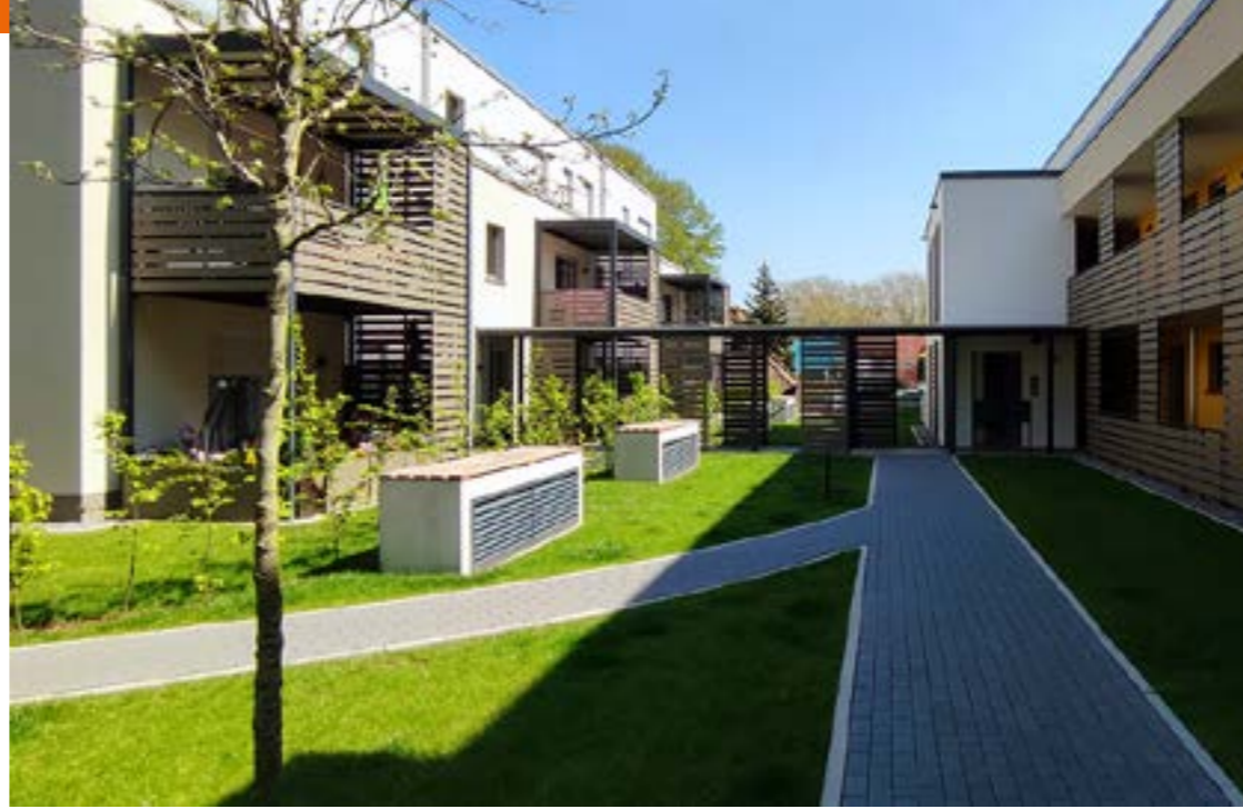
Blick auf die zwei Mehrfamilienhäuser mit insgesamt 20 Wohneinheiten. (© Beckmann Stahl- und Metallbau, Wetter)
