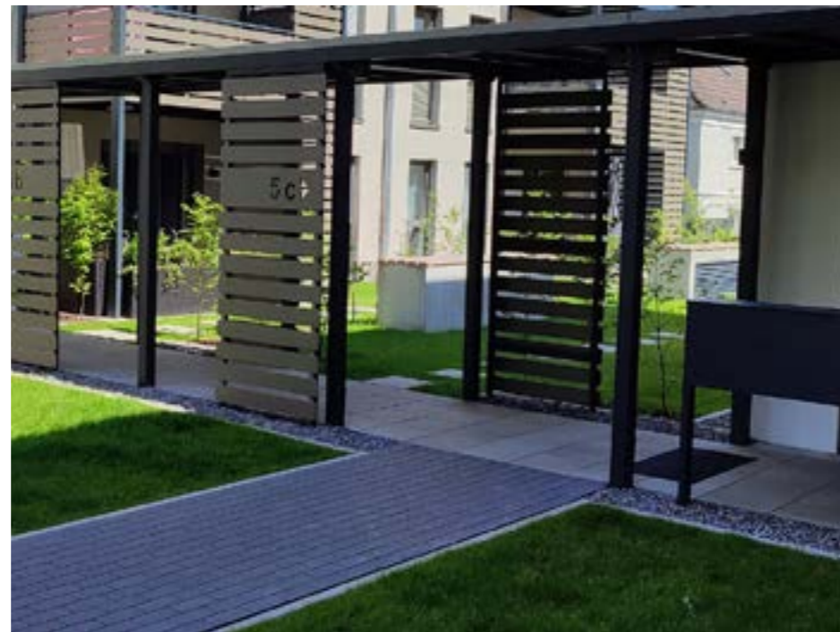
Die beiden Neubauten werden durch einen mit Lamellen bestückten Gang verbunden. (© Beckmann Stahl- und Metallbau, Wetter)
