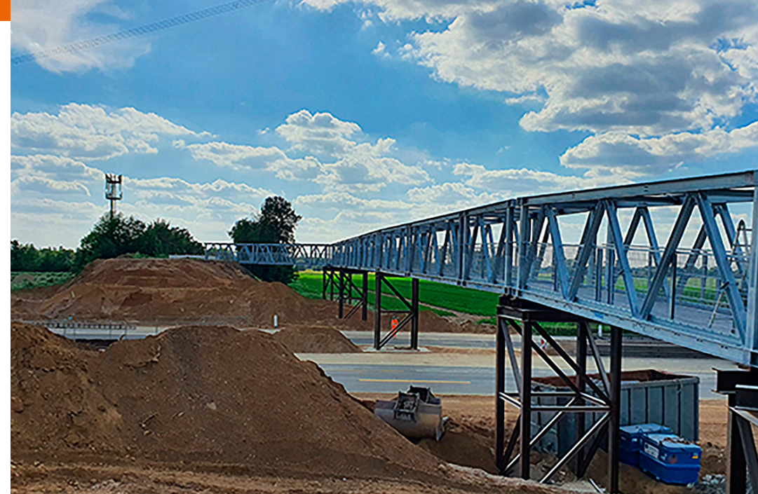
Einen Tag früher als geplant konnten die Arbeiten an der Behelfsbrücke fertig gestellt werden. (© Stahlbau Trepels)
