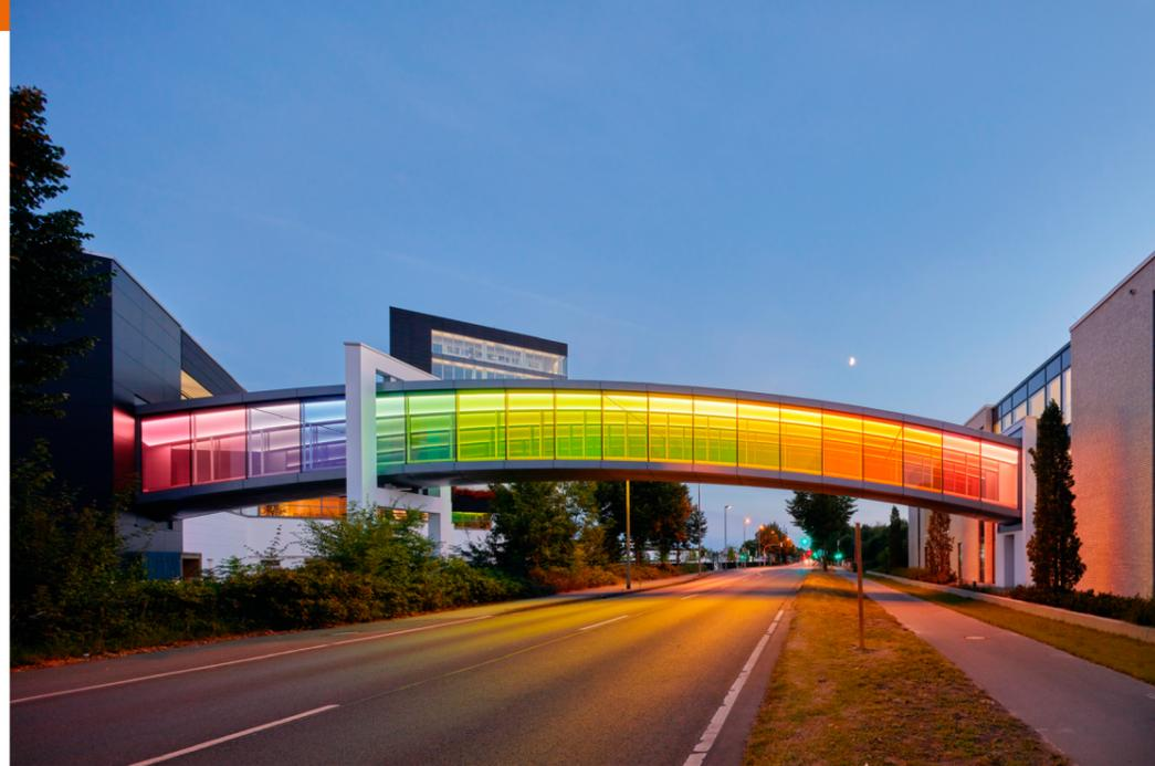
Zwei bogenförmige Stahlträger bilden die komplett verglaste Brücke. (© Brillux)
