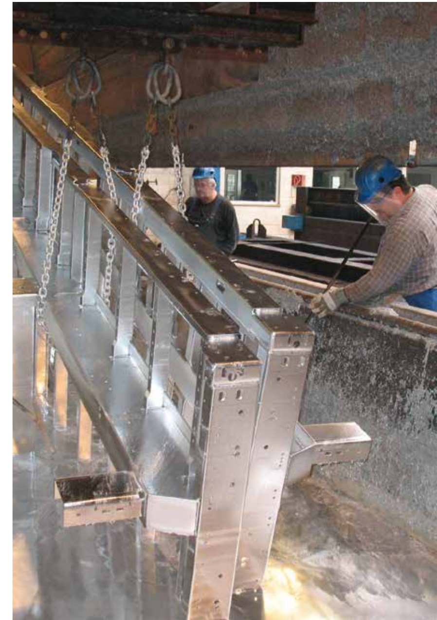
Verzinkung eines Fahrzeugrahmens mit duroZINQ®
