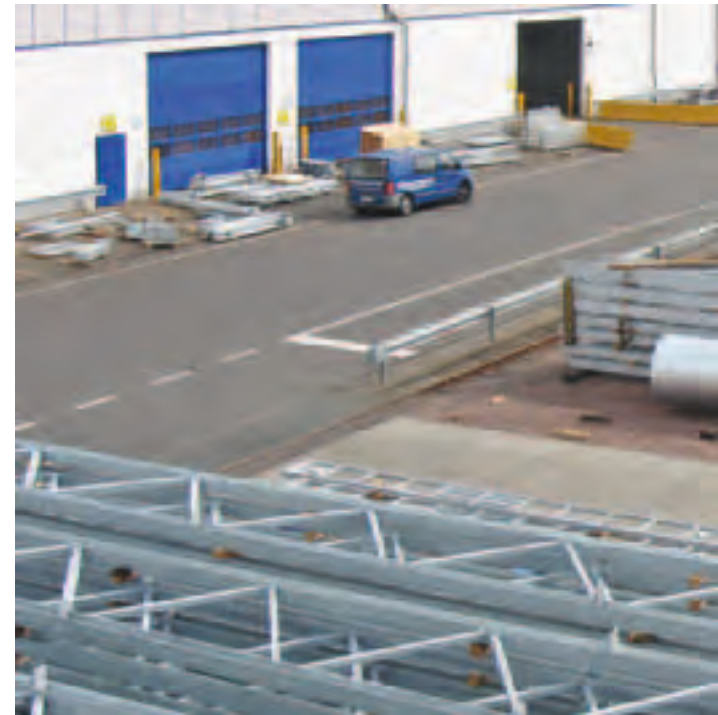
Landsberg: Neubau eines Lagerplatzes von 4.000 Quadratmetern
