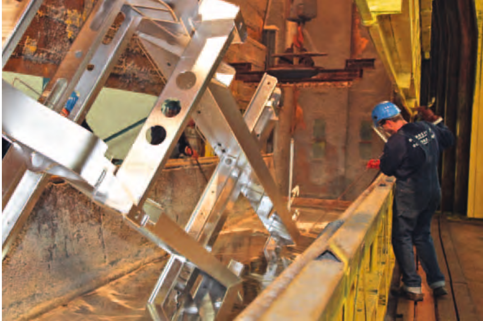
Feuerverzinken einer komplexen Rahmenkonstruktion am Standort Landsberg
