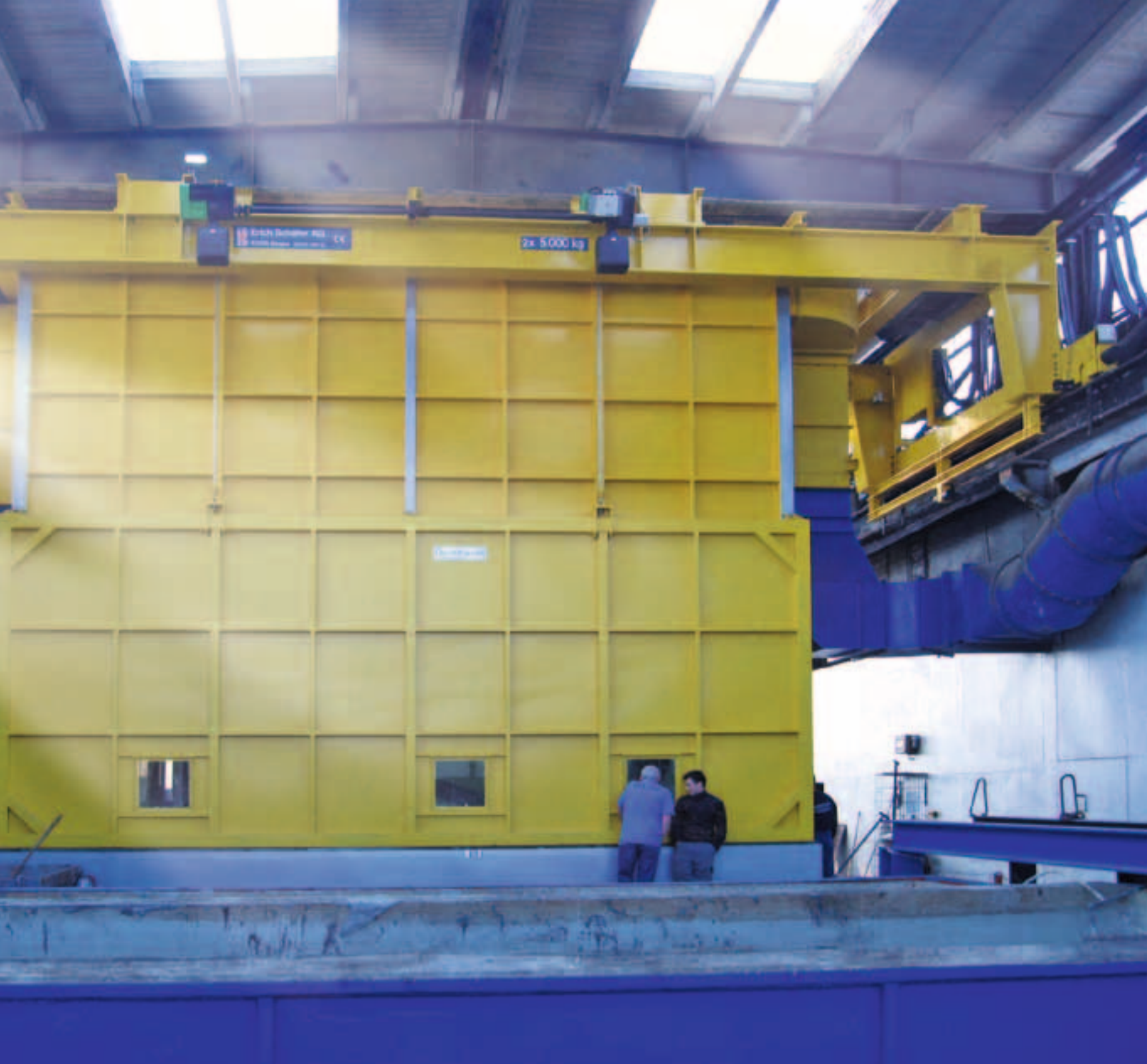
Castrop-Rauxel: Umbau der Kesselanlage von 7 Meter Länge x 2 Meter Breite x 3 Meter Höhe auf 7,5 Meter Länge x 2,2 Meter Breite x 3,5 Meter Höhe mit neuer Kraneinhausung.
