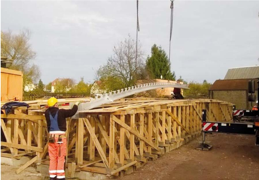
Bild 12. Einheben der Stahlträger in die Schalung (Foto: OST Bau)
