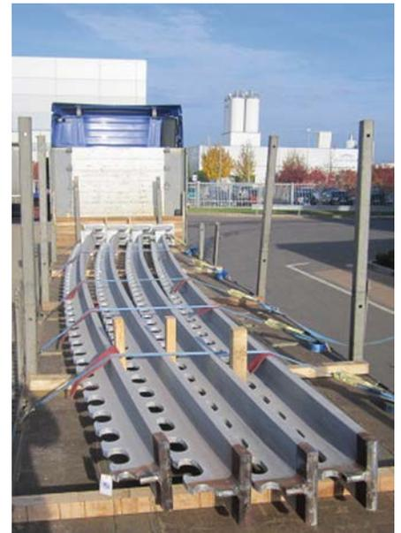
Bild 11. Verladene Träger zum Transport auf die Baustelle
